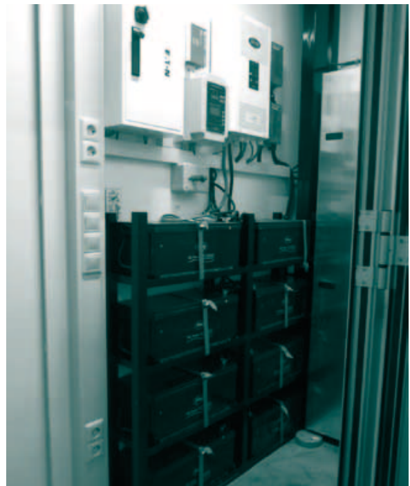
Beispiel einer AGM-Batteriebank, in Verbindung mit einem 3,5kW Wechselrichter
