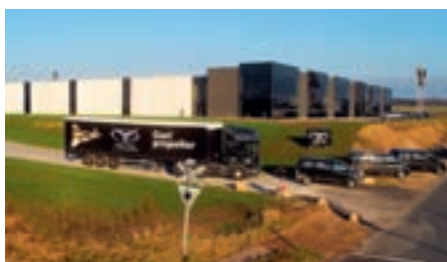
Gori-Firmensitz: Hinter der Glasfassade steckt eine hochmoderne Fertigung
