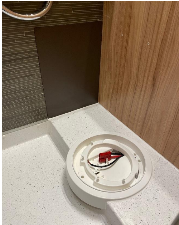
Variante 2 : Rund-Sockel in Duschwanne eingelassen
