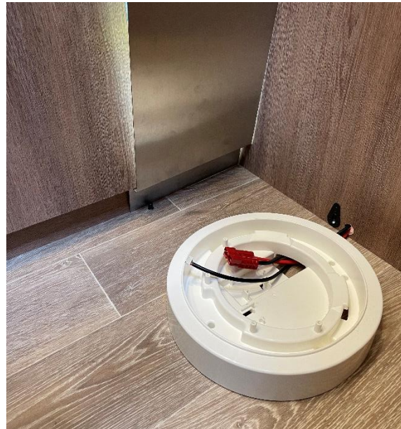
Rund-Sockel verschraubt und Kabel eingezogen
