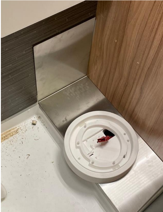
Variante 1: Rund-Sockel auf Edelstahl Blech aufgesetzt
