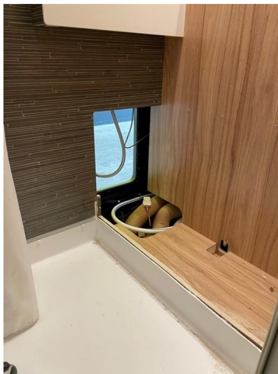
Duschwanne gekürzt und Podest für C1 Sockel gebaut
